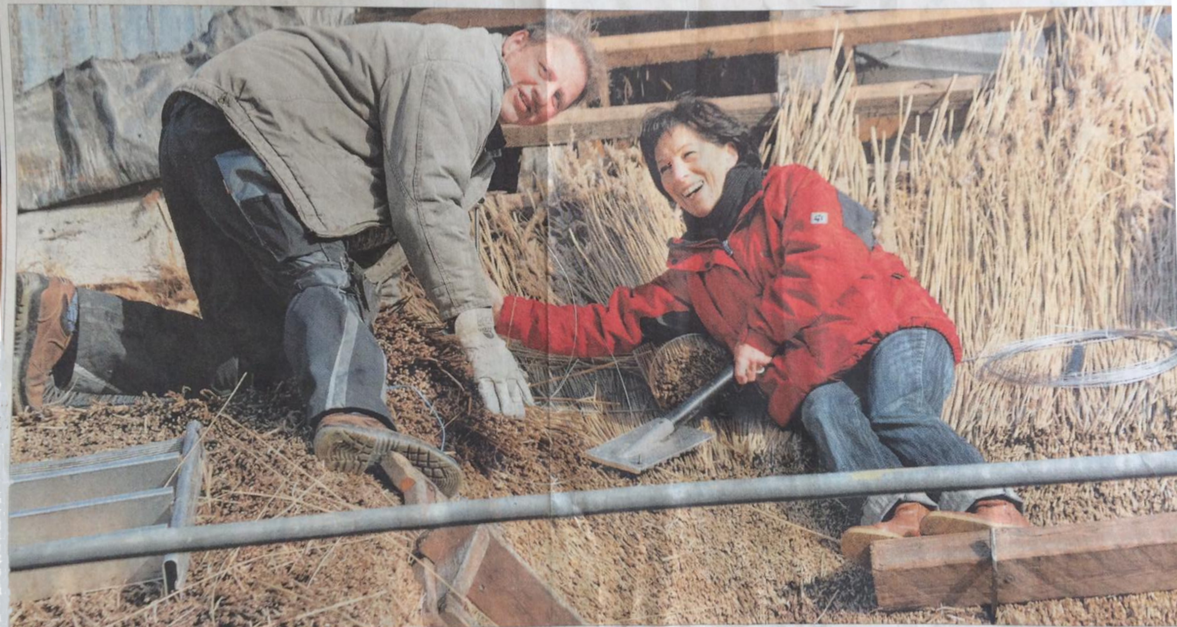
Ein Job in schwindelerregender Höhe: Meister Dirk Teßnow deckt das Dach eines Gebäudes mit Reet ein, OZ-Mitarbeiterin Wilma Welzel streicht es glatt.
